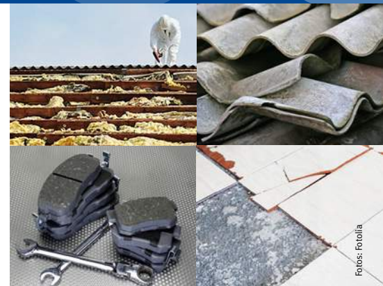
Typische langlebige Asbestprodukte: Isoliermaterial, Dachplatten, Brems- und Bodenbeläge
